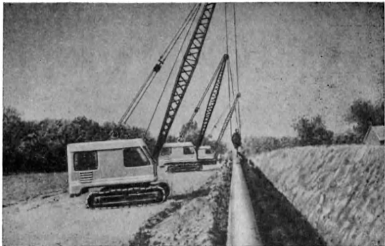
Строительство нефтепровода «Дружба».
